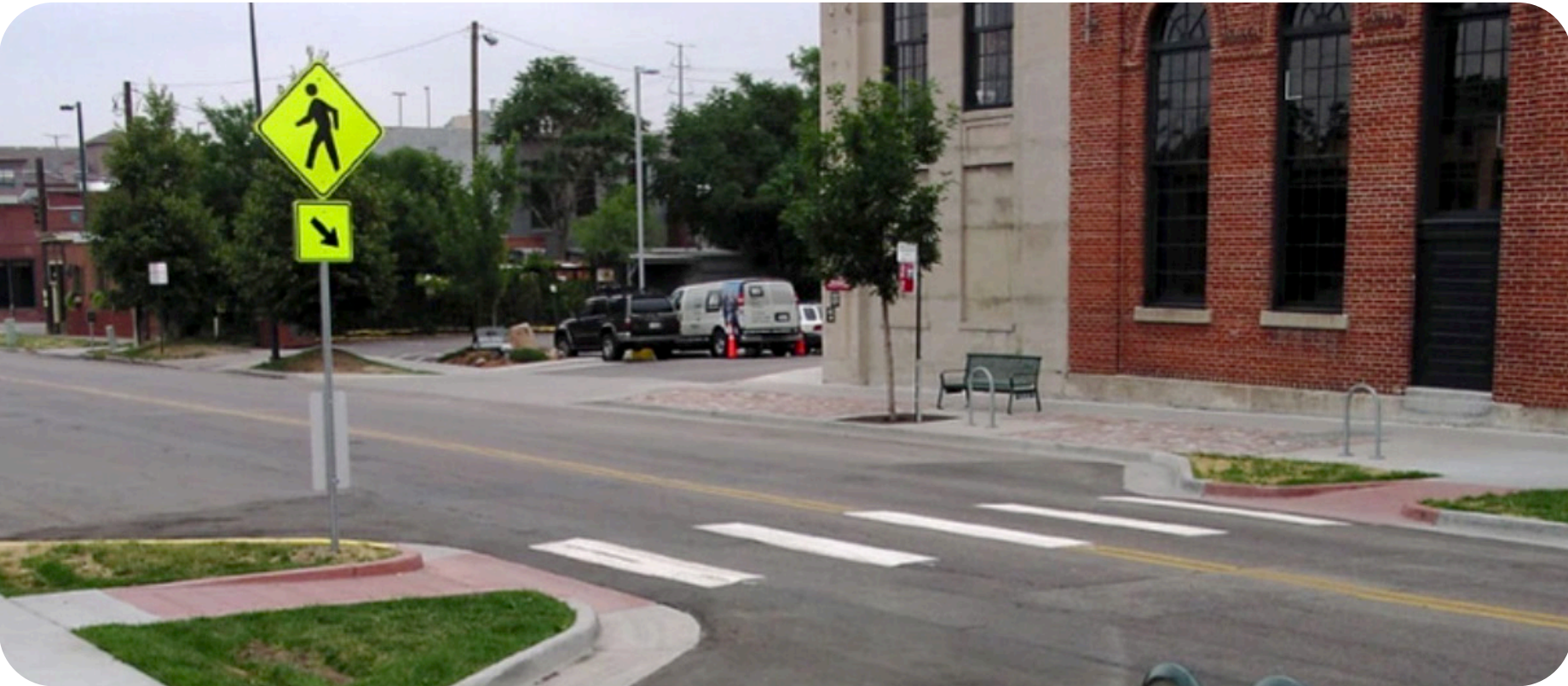
Saillies de trottoir
